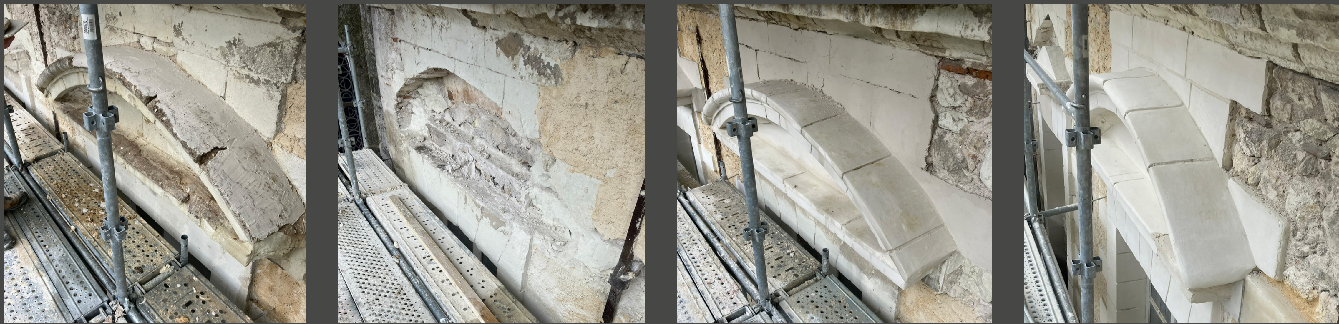
Étapes de rénovation des frontons
